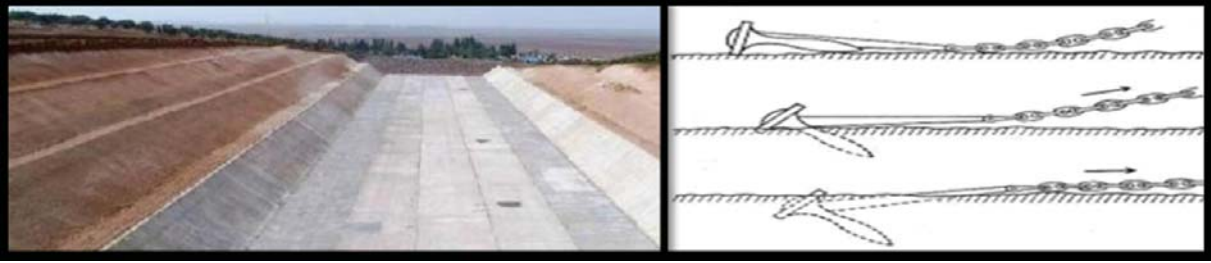
Şekil 12 - Kanal beton kaplaması ve demir atma
